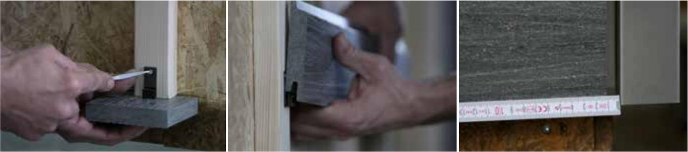
Beginnen Sie mit dem Anbringen der Anfangsklammern auf der Unterkonstruktion. Hierbei ist wichtig, dass die Klammern waagrecht montiert werden und der Bodenabstand ist zu beachten.
