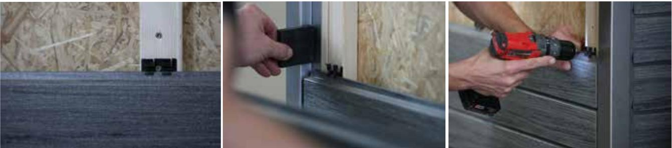
Auf die erste Leiste werden nun die Montageklammern mit der kurzen Seite nach unten aufgesetzt und an der Unterkonstruktion mit beiliegenden Schrauben verschraubt. Schieben Sie nun die nächsten Leisten in die Montageklammern. So können Sie die Fassade Leiste für Leiste nach oben montieren. Prüfen Sie hierbei immer wieder, ob die Leisten noch waagrecht ausgerichtet sind! Beachten Sie den Abstand von min. 6 mm zu festen Bauteilen.
